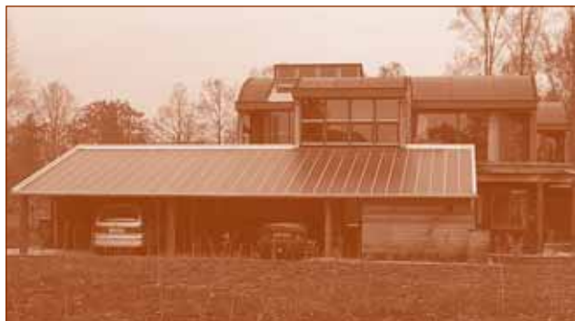
Amorfe PV-film geïntegreerd op metalen dakbanen met staande naad op privaatwoningen te Groenlo, Nederland (Bekaert BESS-Europe)
