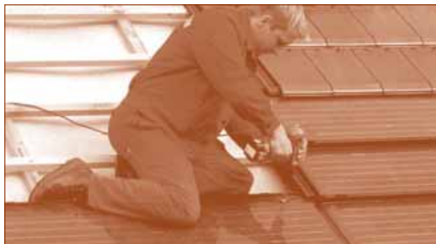
Integratie van PV-shingle voor tegelpanen (Lafarge Braas)
