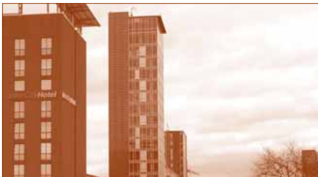
PV-modules als renovatie van de gevel van een kantoortoren in Freiburg (Duitsland)
