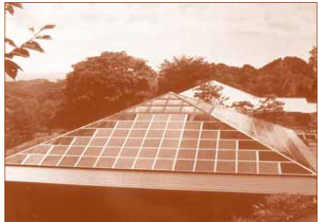
Ook op 'moeilijke' daken kunnen PV-modules geplaatst worden; aan de randen van de driehoek zijn dummy-panelen toegepast (IEA Task 7)
