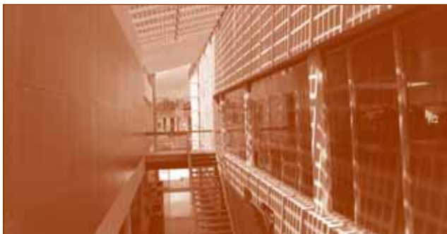
Semitransparante PV-modules op het atrium van een bedrijfsgebouw (Turbowinds)
