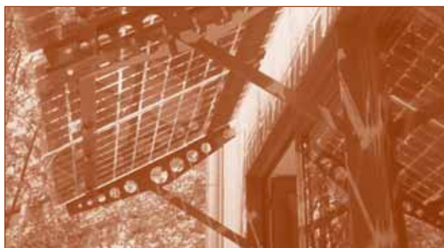
Semitransparante PV-modules als vaste zonnewering (Imec)
