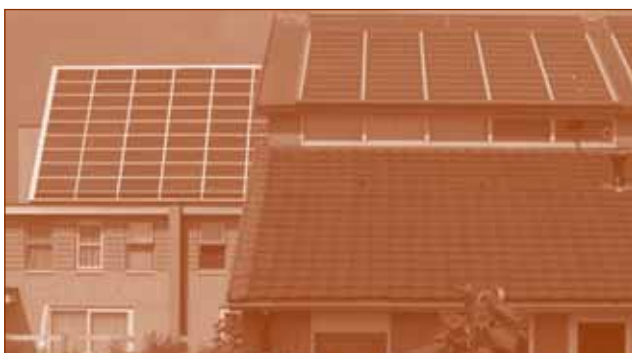
Twee PV-daken uit het 1 MWp-project 'Nieuwland' bij Amersfoort (NL); vooraan rechts PV-modules met bovenaan thermische collectoren, achteraan een prefab dakelement met PV-modules (Novem)
