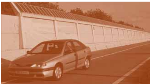
Op goed geïntendeerde geluidswanden langs autowegen is ook plaats voor lange stroken PV-modules (autoweg A27 Utrecht-Amsterdam)
