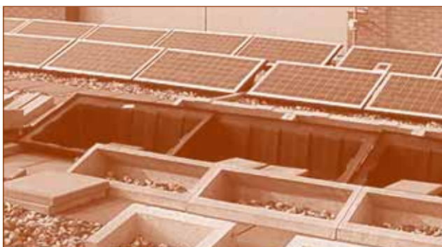
Verschillende standaardsystemen in beton of kunststof voor opstelling van PV-modules op een plat dak (Ecofys)
