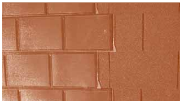
Amorfe PV-shingle tussen klassieke asfaltshingles (Bekaert, BESS-Europe)
