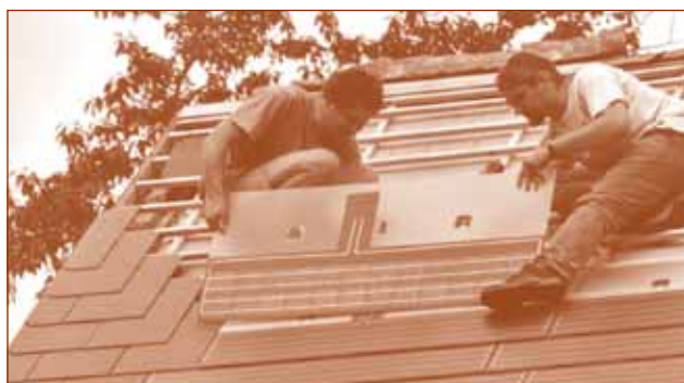
Integratie van PV-shingle tussen vezelcementleien (Soltech, Eternit)
