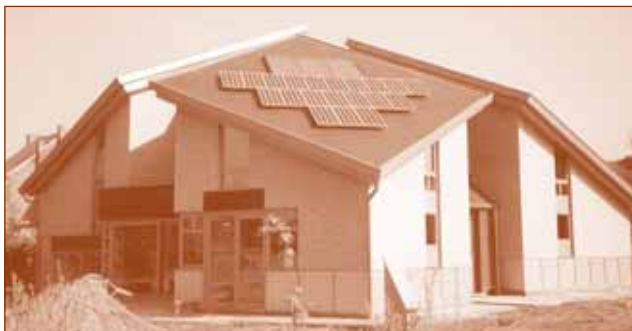
Netgekoppeld PV-systeem op een leiidak te Sint-Katelijne-Waver (Solar Technics)
