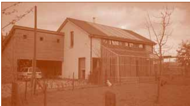
Dakgeïntegreerd PV-systeem van 3,4 kWp op dak in tegelpanen te Moorsel (arch. Eeckhout en Van den Broecke, Gent)
